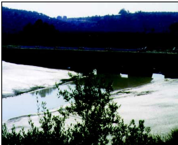
Figura 2. Erosión: efectos indeseables en la colmatación de canales y presas.
